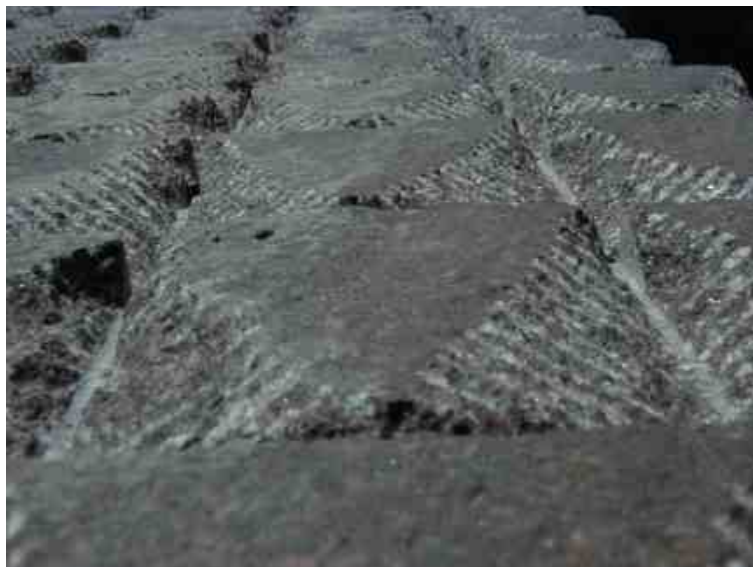
Struktur geschnitten (oben) und behauen (unten)
