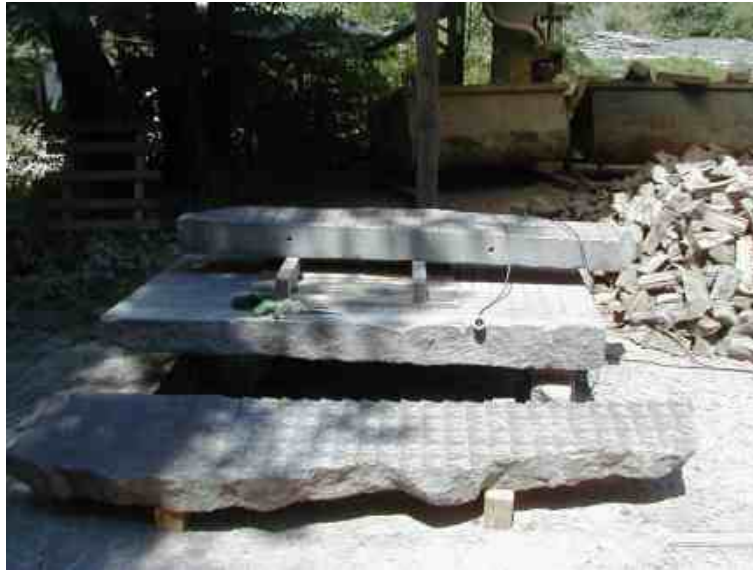
Vorarbeiten im Steinbruch am Montiggel in Eppan
